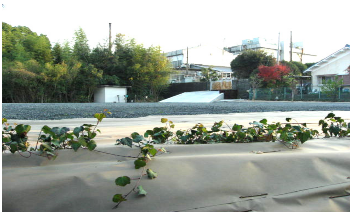
緑地化し、整備した工場の北境界
